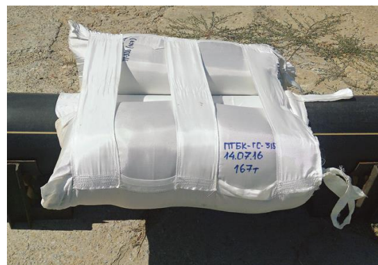
ПТБК-ГС на трубопроводе
